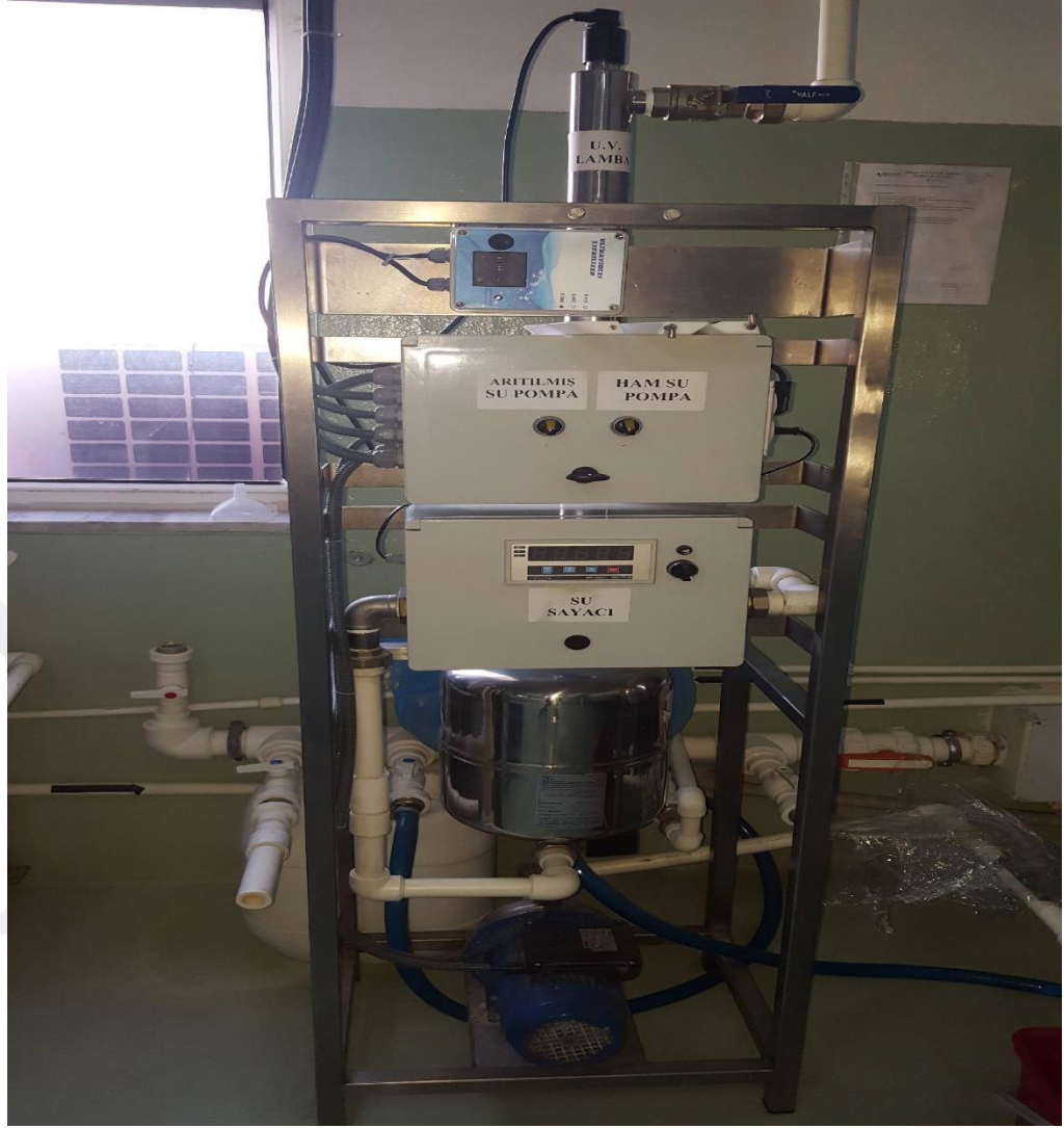
Şekil: 5.4.Arıtılan suyun geçtiği UV Lamba
