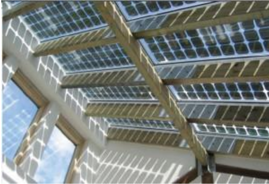
Şekil 4.21 Çatı İle Bütünleşik Fotovoltaik Paneller
