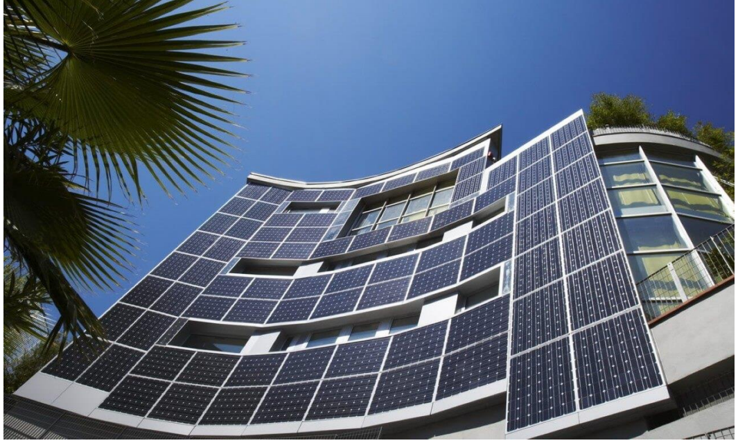
Kaynak: http://www.kranemfg.com/pv-glass-facades Şekil 2.26 Fotovoltaik Panellerin Cephede Uygulanması
