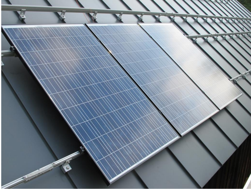
Şekil 4.22 Çatı İle Bağımsız Fotovoltaik Paneller
