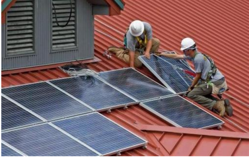
Şekil 2.21 Çerçevesiz Fotovoltaik Panellerin Çatıya Uygulanması
