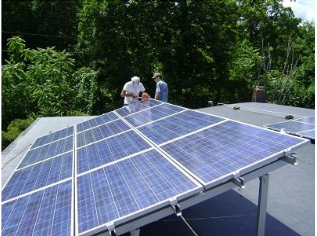
Şekil 2.22 Çerçevesiz Fotovoltaik Panellerin Düz Çatıya Ek Strüktür İle Uygulanması
