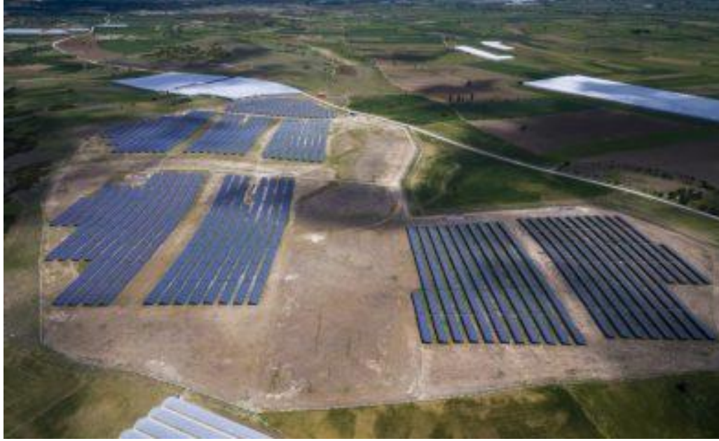
Kaynak: ANTSA Enerji, Antalya Şekil 5.5 Güneş Enerji Santrali, Burdur
