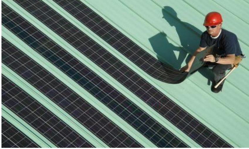
Kaynak: http://www.enerjibes.com/solar-cati-teknolojileri-nelerdir Şekil 4.10 Solar Halı Çatıda Uygulanması
